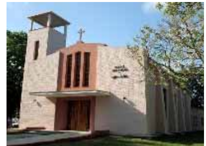
Vista actual de la iglesia de Santa María y Santa Elena, en Tarará, consagrada por el cardenal Jaime Ortega la mañana del pasado sábado 5 de abril.
